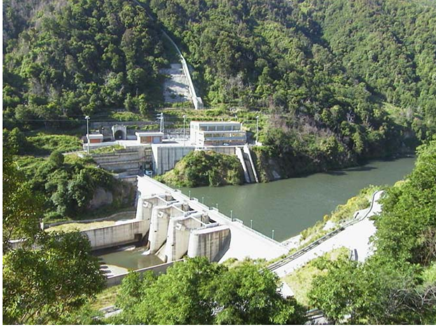
Centrale idroelettrica a salto di Satriano (CZ)
