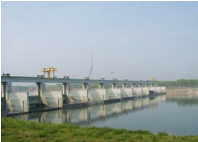
Centrale idroelettrica ad acqua fluente di Isola Serafini (PC).
